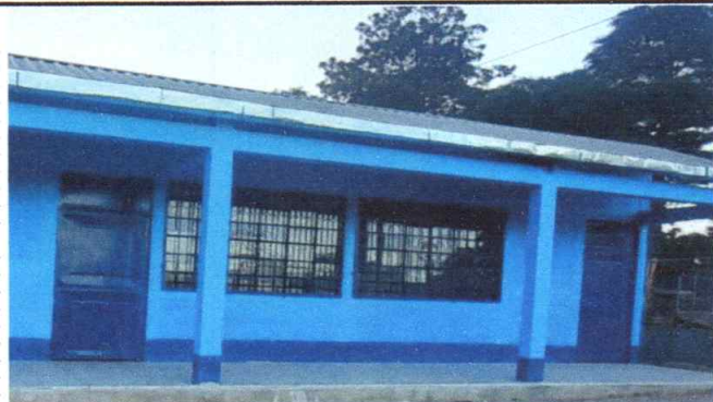
Foto 1: Canales de metal instalados
