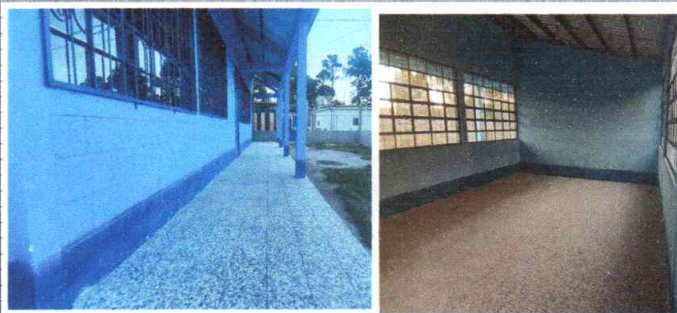
Foto 6: Piso de cemento instalado
