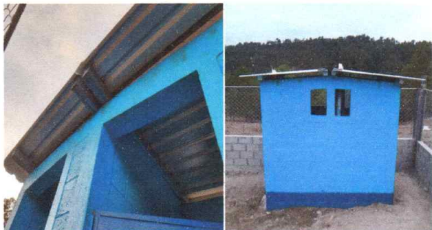
Foto1: Cubierta de lámina y estructura de soporte instalado
