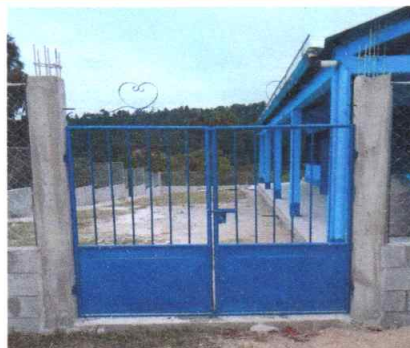
Foto 2: Portón de metal instalado
