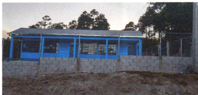
Foto 4: Muro perimetral terminado
